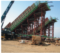
1. 사교각 벤트 설치 및 철근조립
